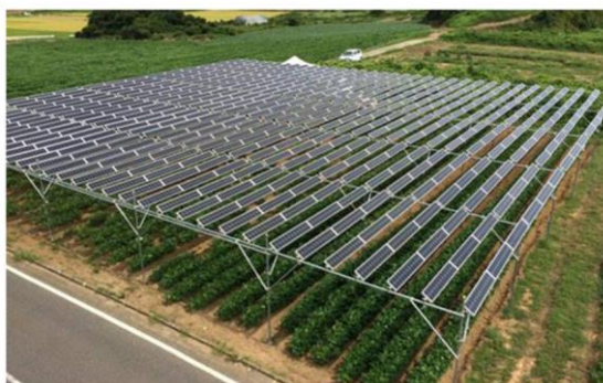
ภาพที่ 5.10 แสดงการแชร์พลังงานแสงอาทิตย์ (Solar Sharing) เพื่อใช้ปลูกพืช ที่มา: ซีรเกียร์ดี เกิดเจริญ (2560)
